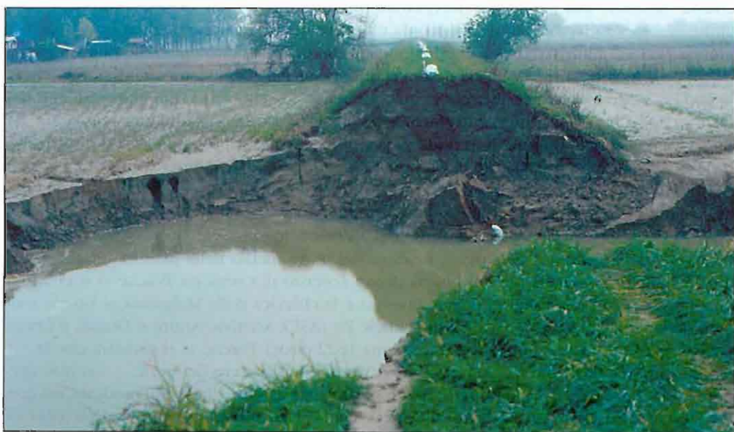
Foto 1: un bodrio formatosi per la rottura di un argine golendale durante un evento di piena.
