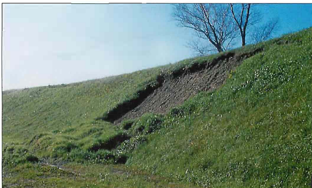
Foto 4: fenomeno di framamento superficiale.
