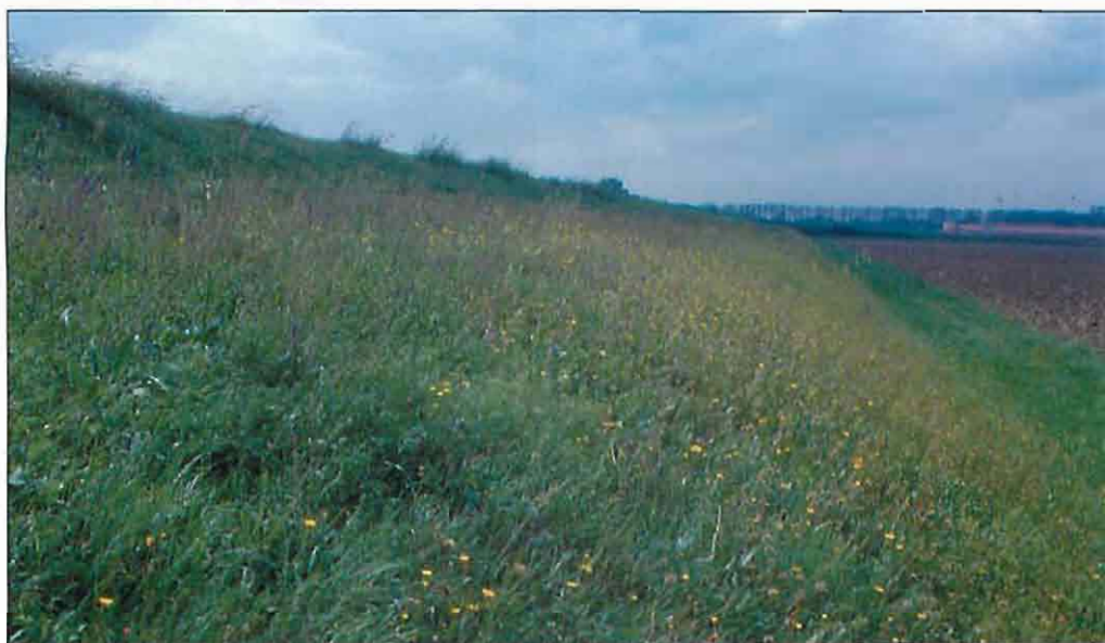
Foto 23: argine maestro in tarda estate.
