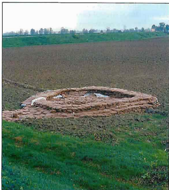
Foto 2: un fontazzo formatosi sul lato esterno dell'argine maestro durante un evento di piena.
