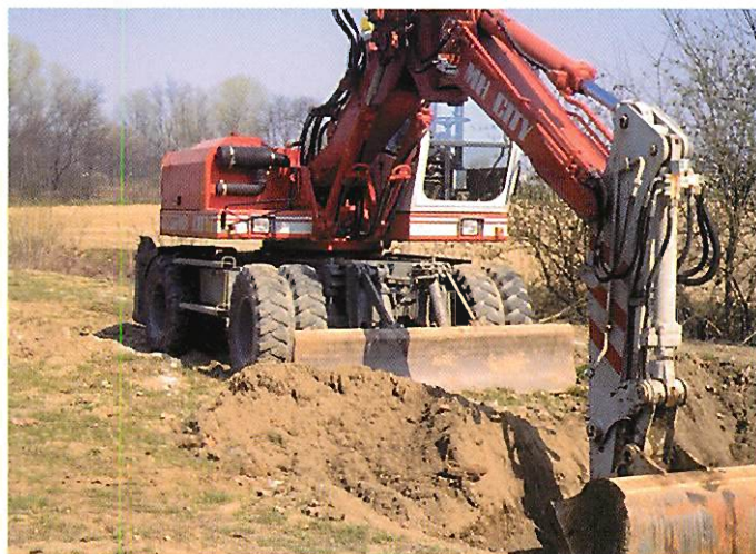
Scavo di un nuovo stagno a Castellone
