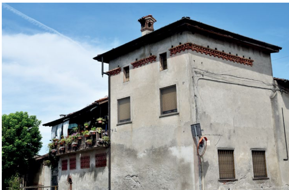
13 -Torre colombaia – Misano Gera d'Adda (Bg), centro abitato.
