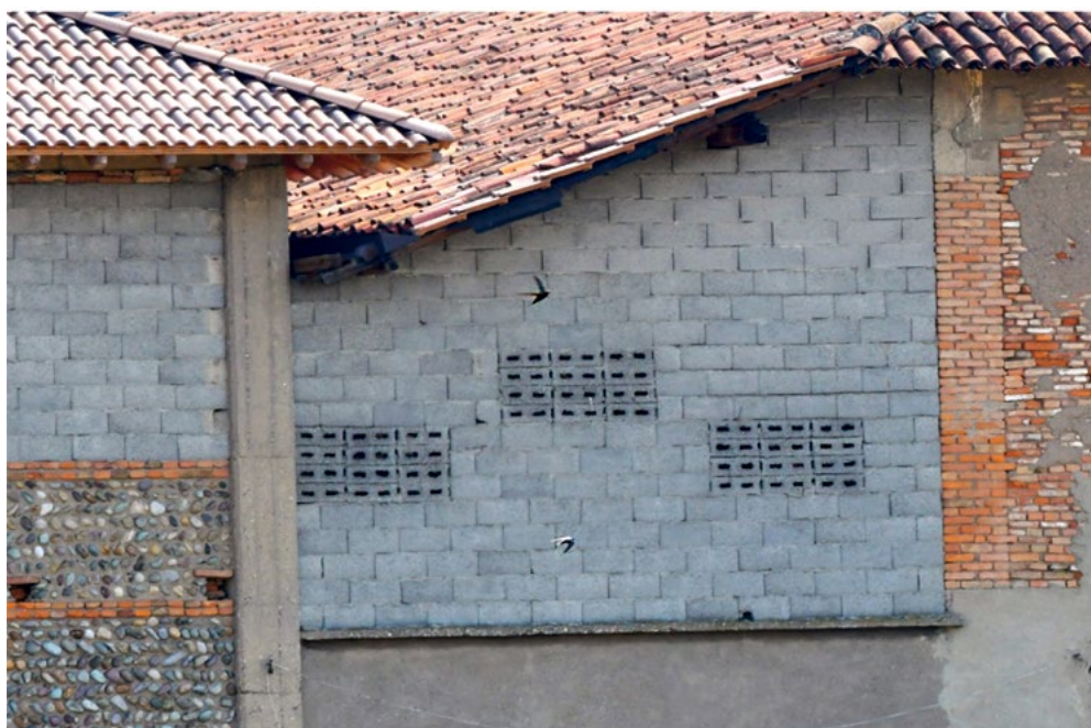
14 - Rondonera di recente costruzione – Morengo (Bg), isolato agricolo.
