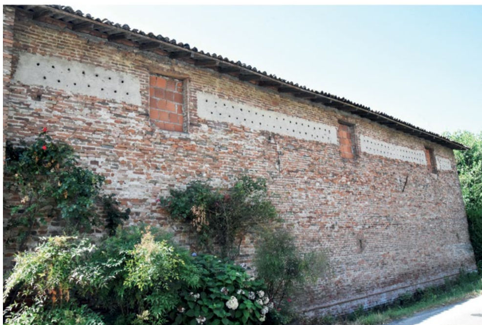
21 - Passerera - Capergnanica, loc. Passarera (Cr).
