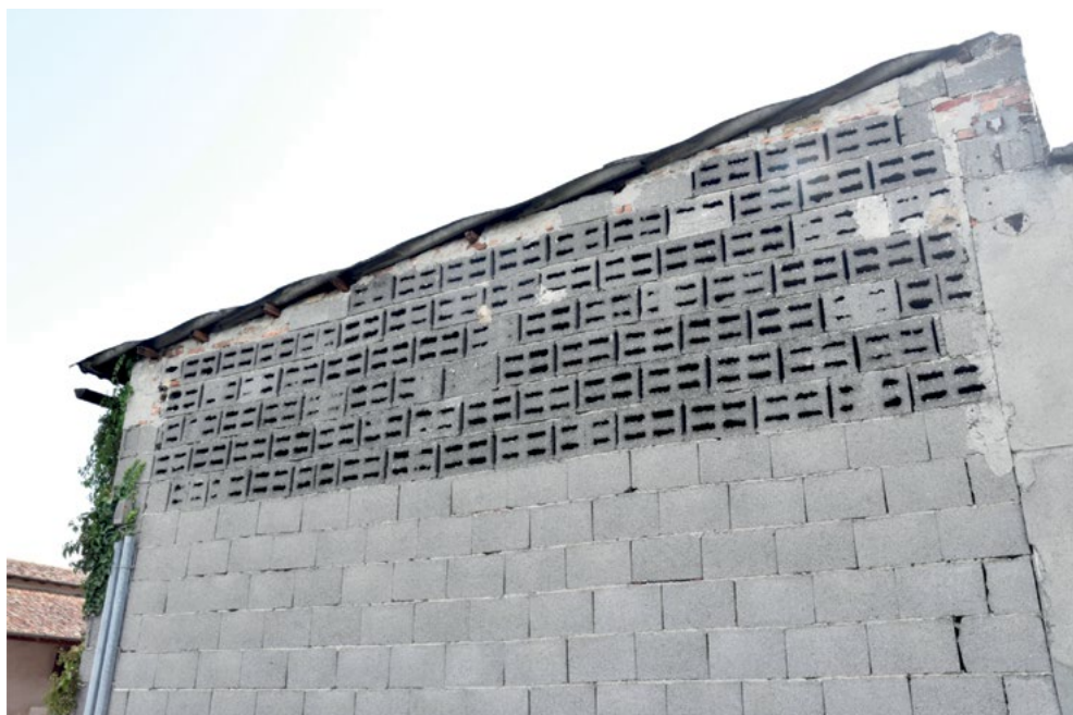
30 - Passerera rondonaia - Quintano (Cr), centro abitato.
