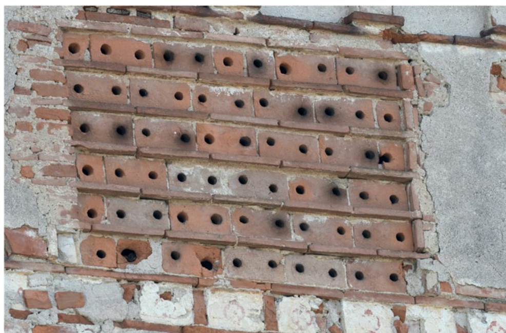
15 -Torre passerera – Mornico al Serio (Bg), con chiari segni del passaggio di rondoni e passeri.
