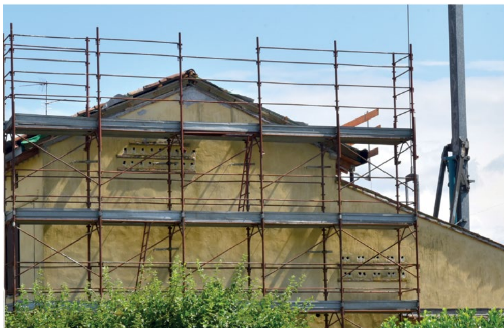
8 - Passerere in riparazione – Capergnanica (Cr), periferia.
