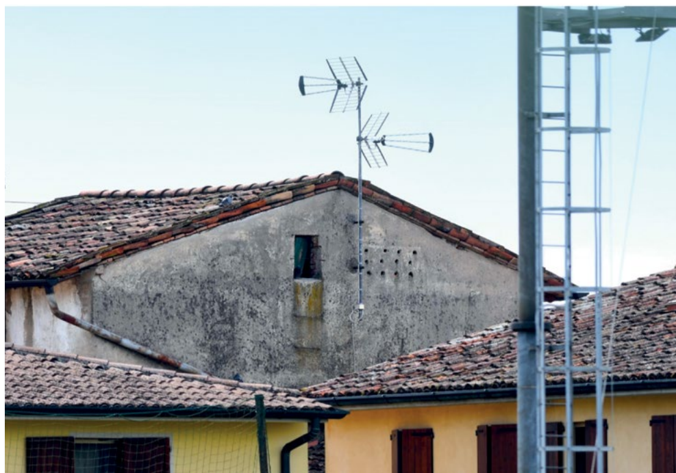
25 - Passerera - Pieranica (Cr), centro abitato.
