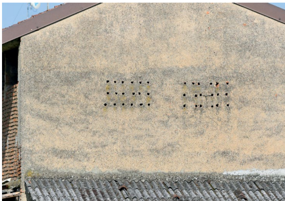
23 - Passerera - Pieranica (Cr), centro abitato.
