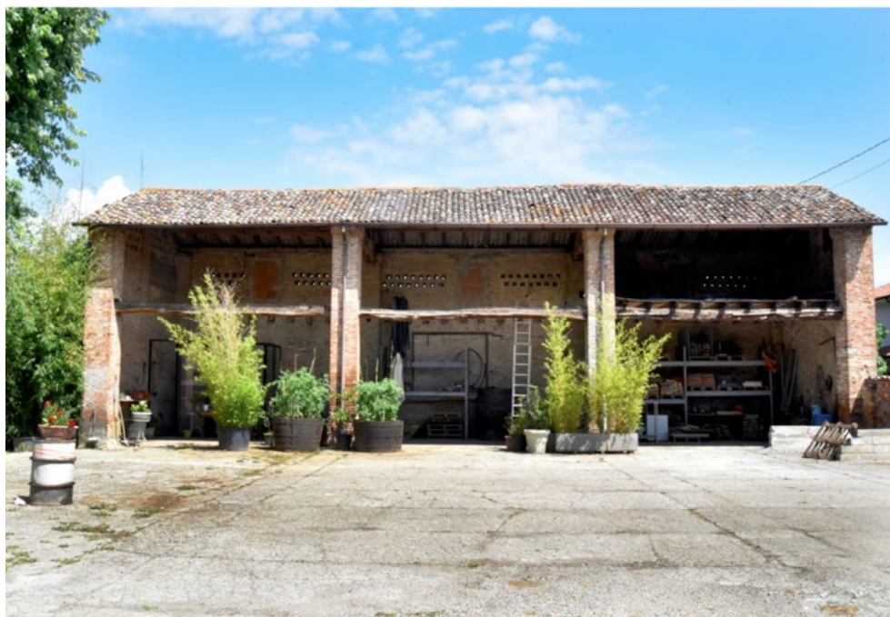
Porticato a passerera, in loc. Passarera di Capergnanica. Sulla parete di fondo si intravedono i fori pas-santi in corrispondenza di ogni singola nicchia.
