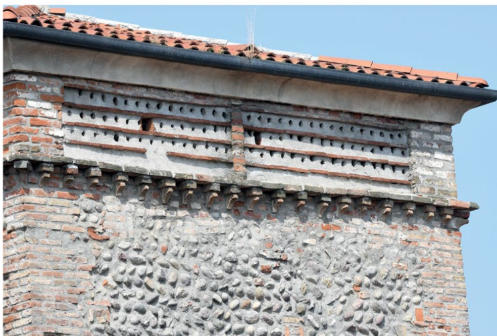
38 -Torre passerera – Mornico al Serio fraz.Torre de' Passeri (Bg) – dettagli.
