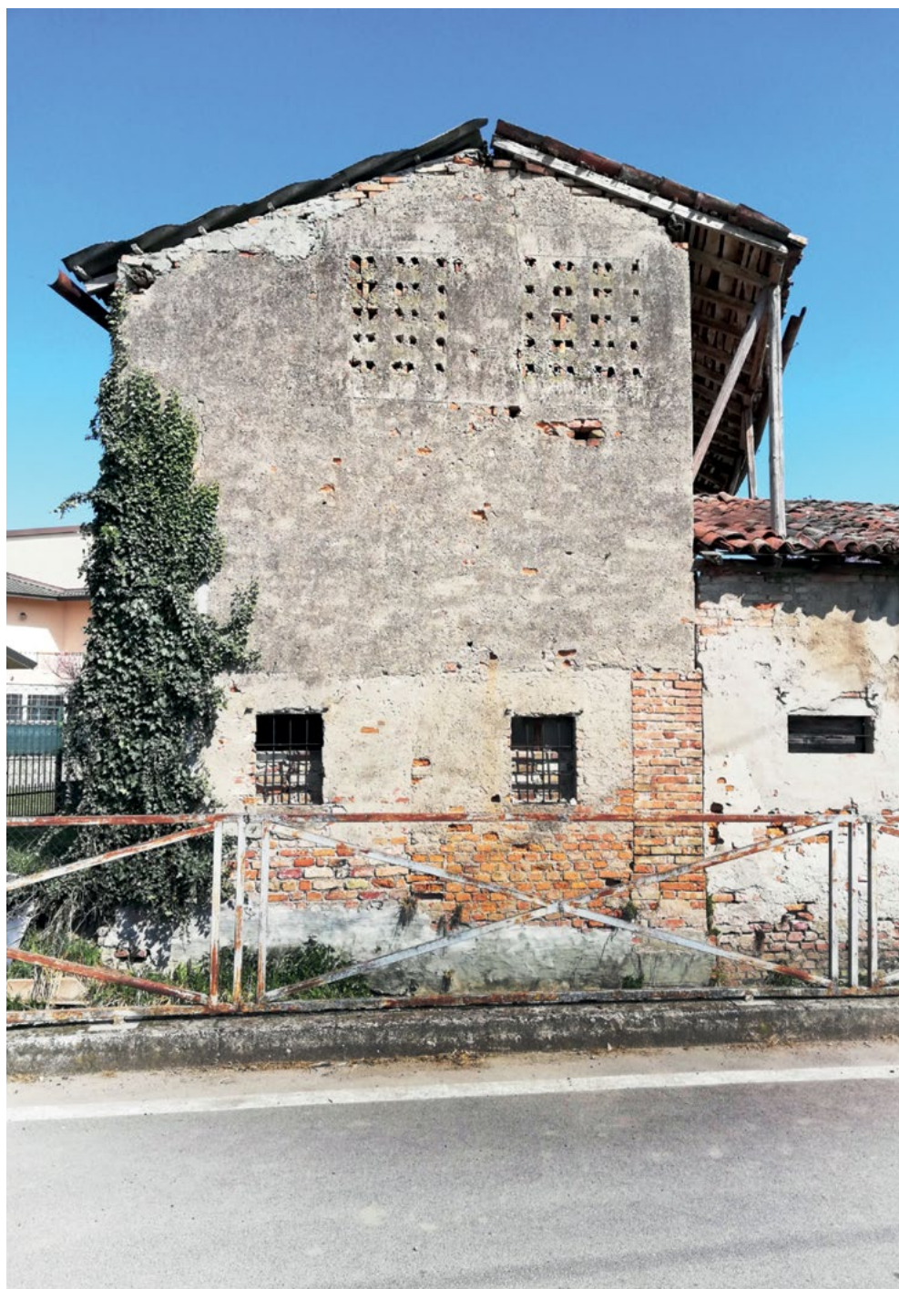
22 - Passerera - Pieranica (Cr), centro abitato.
