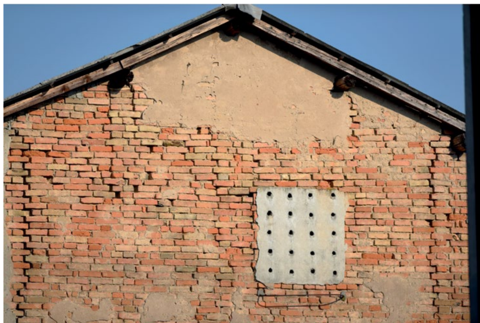
24 - Passerera - Pieranica (Cr), centro abitato.
