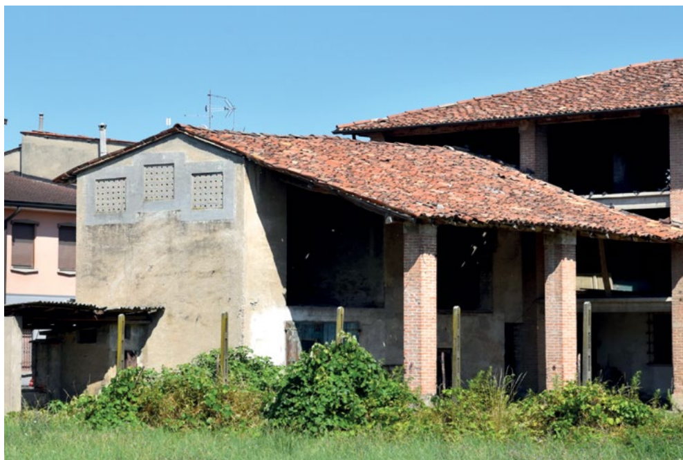
18- Passerera - Mozzanica (Bg), centro abitato.
