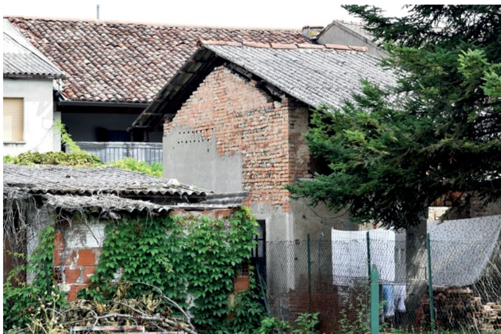
29 - Passerera - Pieranica (Cr), centro abitato.
