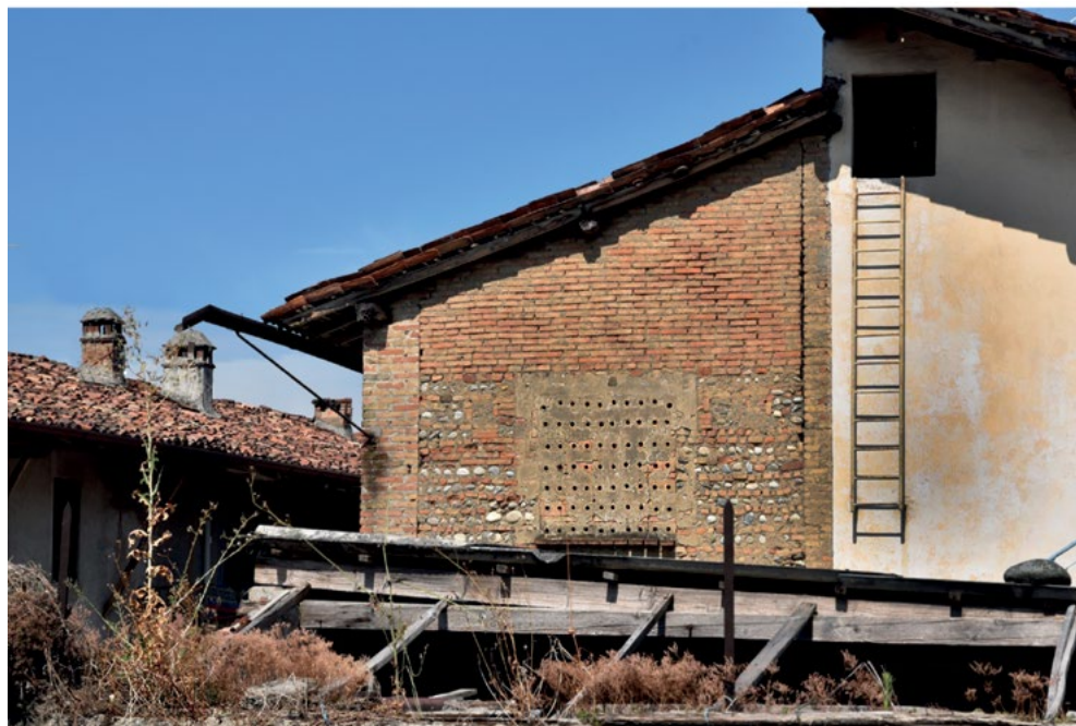
6 - Passerera - Calvenzano (Bg), centro abitato.
