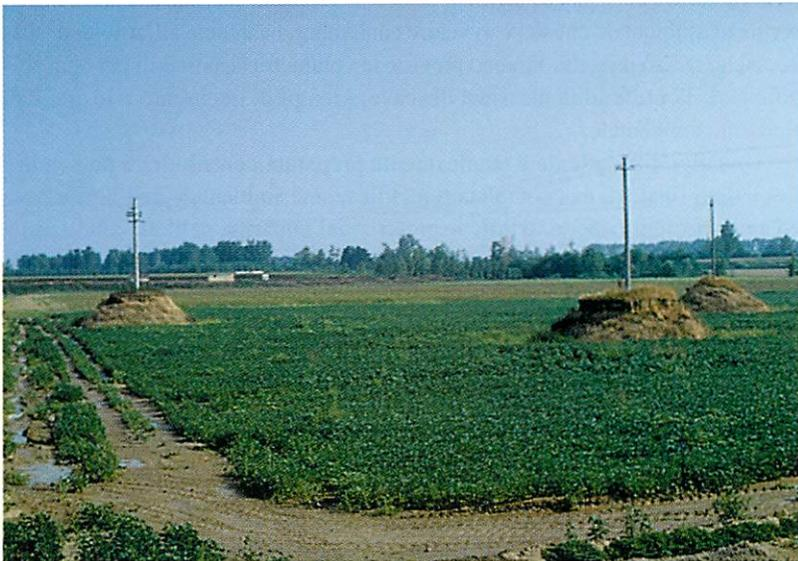
**Foto 2 - Cava in asciutto in cui risaltano i sostegni dell'elettrodotto lasciati, in condizione di insicurezza, sospesi su esili "isolotti" di terreno, in contrasto con le norme di polizia mineraria che prevedono l'abbassamento degli stessi alla quota del piano di campagna neofornato.**
